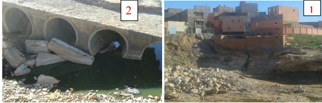
الصورة رقم 1: استيطان المباني بمجرى الواد الصورة رقم 2: عدم ملائمة القناطر للمعايير التقنية
